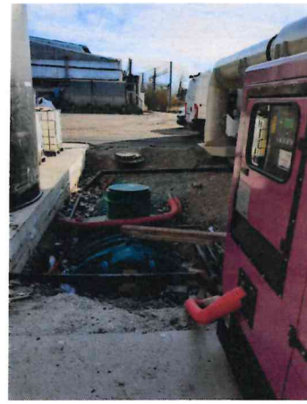
Cuve enterrée lixiviat (nouveaux tunnels)
