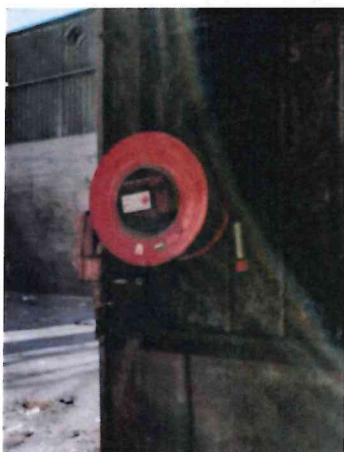
Bâtiment stockage OMR : RIA installé
